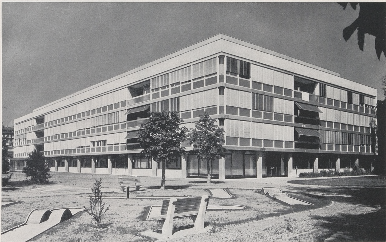
Façades Sud et Ouest
