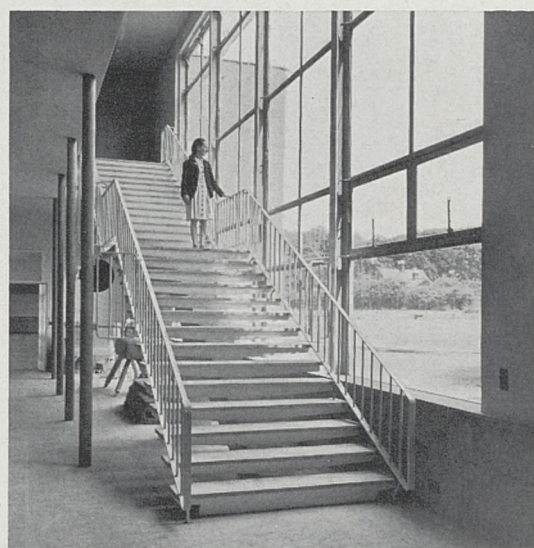
En haut: centre industriel de Knutsford, 1950. Maquette. En bas: école secondaire Barclay à Stevenage (Hertsfordshire), 1950. Détail d'un escalier et bâtiment des classes scientifiques
