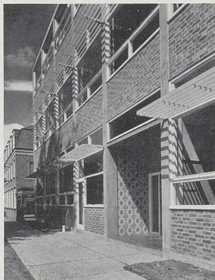
Collège Southlands à Wimbledon (Londres), 1955-1957. En haut: bâtiment principal. A droite: détail du bâtiment principal et détail de l'escalier. En bas: pavillon du foyer
