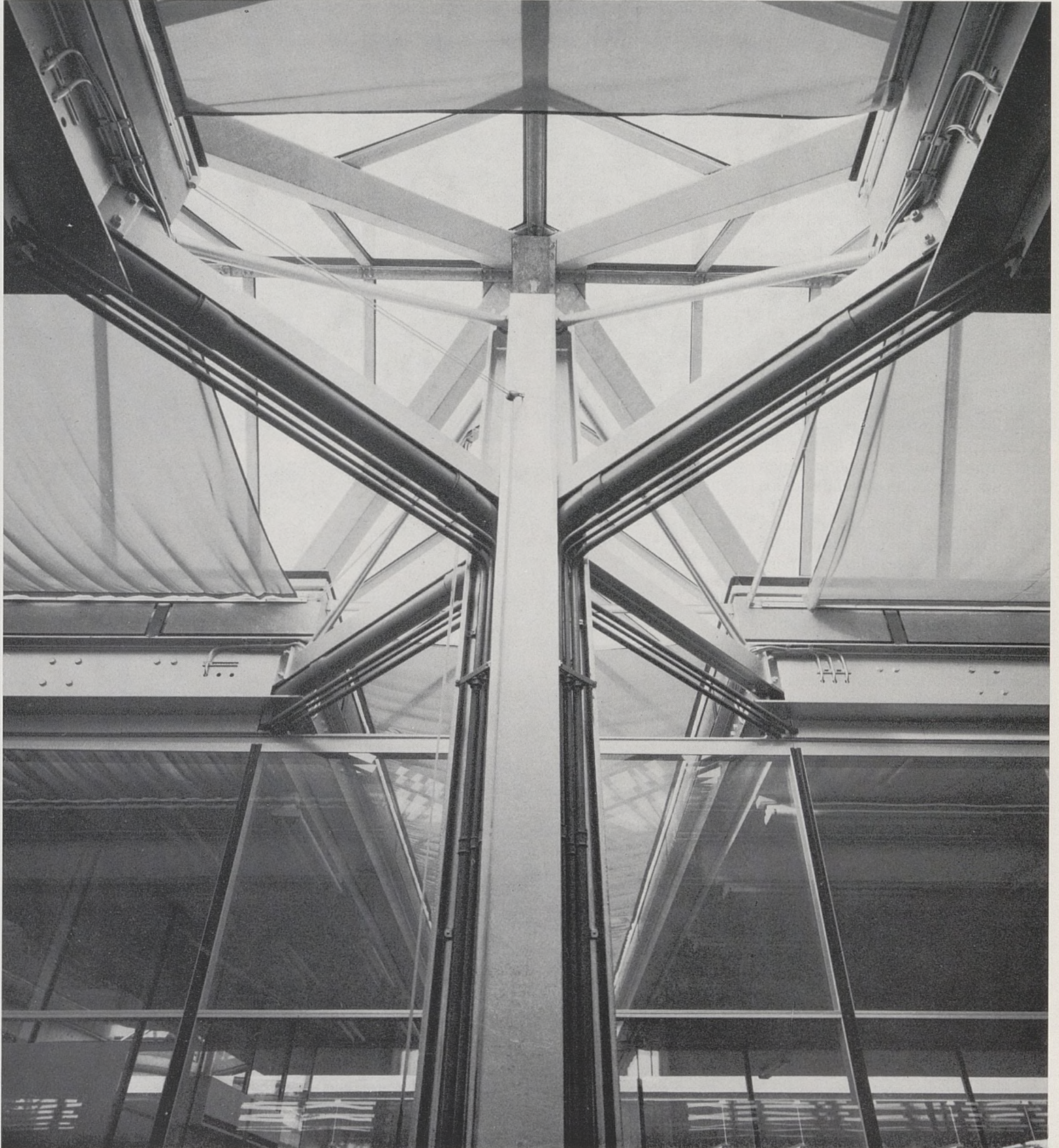
Détail intérieur de la structure suspendue des halles.
