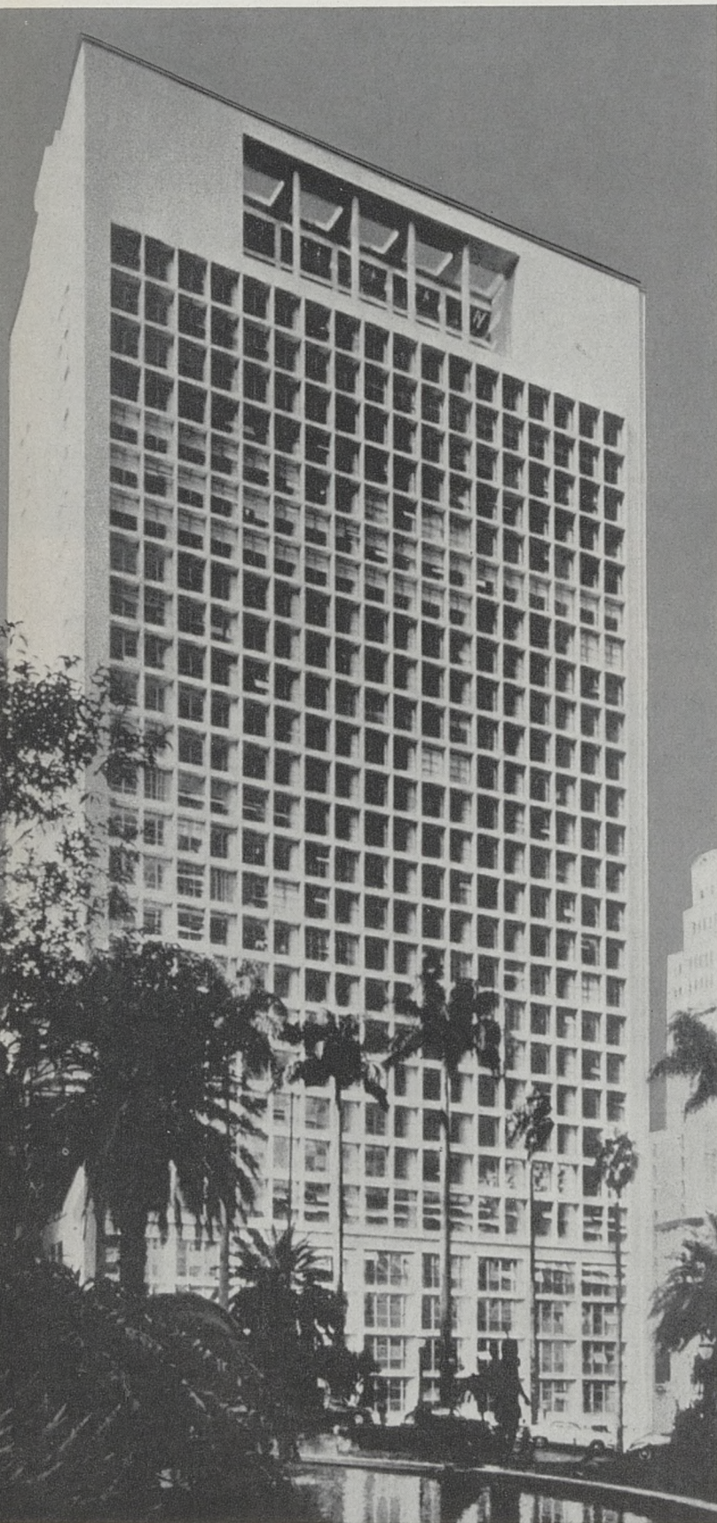
A gauche: Lucjan Korngold. Immeuble de la Compagnie Brésilienne d'investissements, « Esplanada » à São-Paulo (Brésil), 1947-1950. Vue de la façade Sud. C'est l'édifice à ossature en béton armé le plus haut d'Amérique. La hauteur totale de la structure, depuis le fond des fouilles jusqu'à la terrasse mesure 112 m. En haut: Henrique E. Mindlin. Hôtel de 600 appartements à Praia Vermelha (Rio-de-Janeiro, Brésil), façade principale. En bas: Marcelo, Mauricio et Milton Roberto. Bâtiment d'administration de la Direction de l'Institut des Assurances d'Etat à Rio-de-Janeiro (Brésil), 1944. Façade Nord
