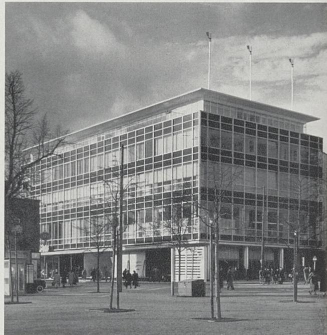
Centrale de chauffage de Heizkraftwerk S. A. Munich. Façades Gartner en aluminium et verre avec fenêtres à pivots horizontales. Surfaces 3700 m<sup>2</sup>.
