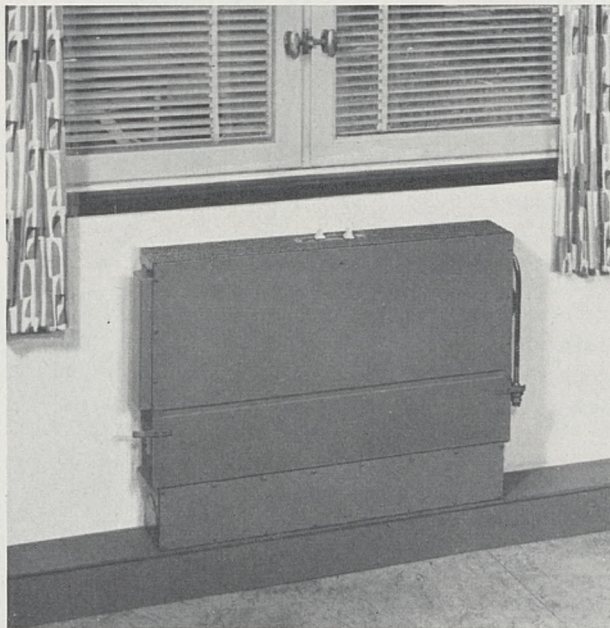
Fig. 3. Appareil individuel de climatisation « Velovent » sans sa protection.
