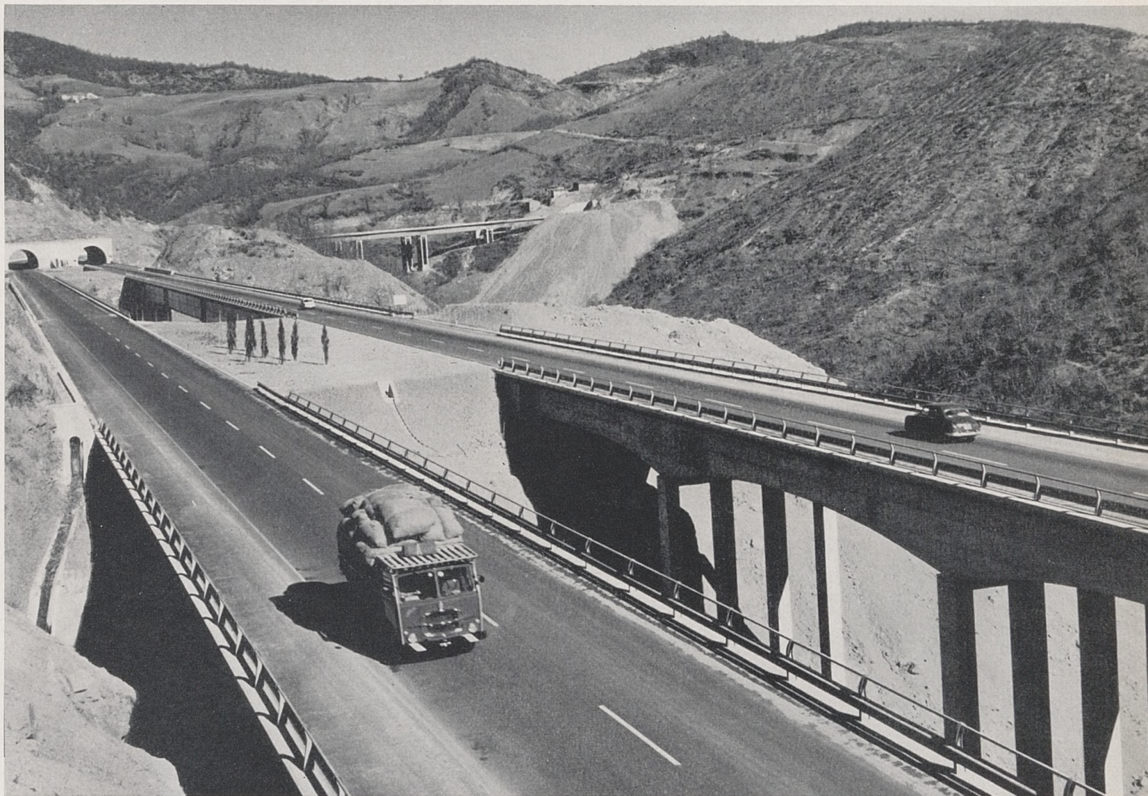
1 Vues générale des viaducs « Macinaie », « Goretta » et « Castellare »
