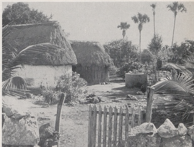
Les cases des villages mayas du Yucatan: murs ovales de pisé et toits de chaume, comme il y a un millénaire
