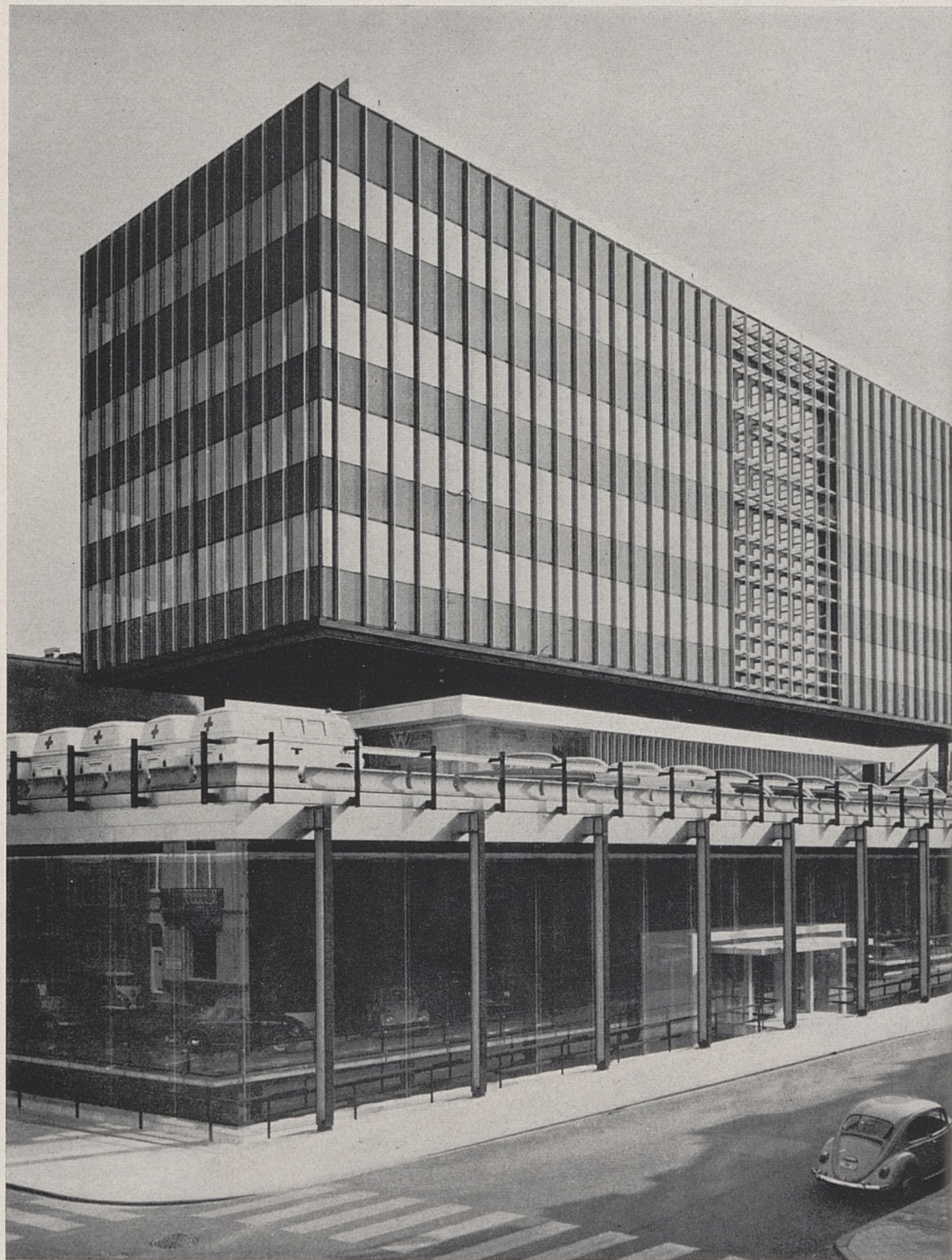
Vue extérieure du bâtiment fini. a) partie inférieure et parking (infrastructure) salles d'exposition et entrée des visiteurs. b) partie supérieure: superstructure (bureaux)
