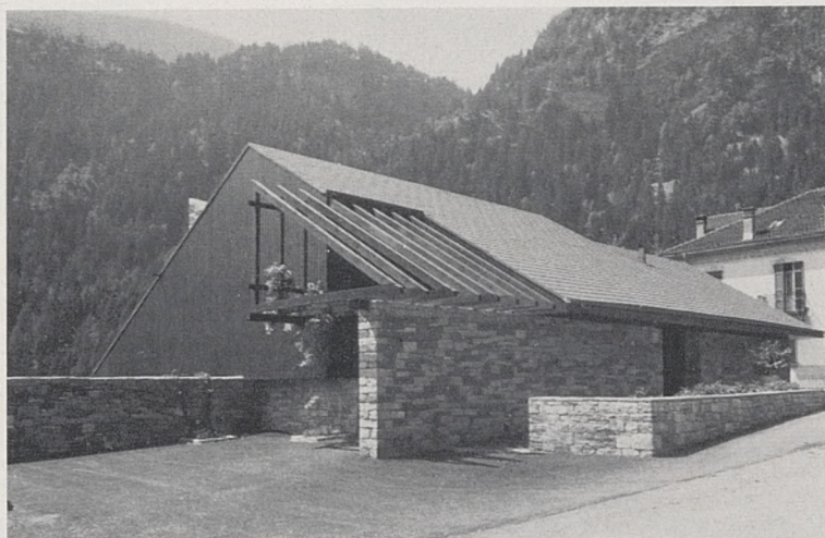
Façade nord — Entrée
