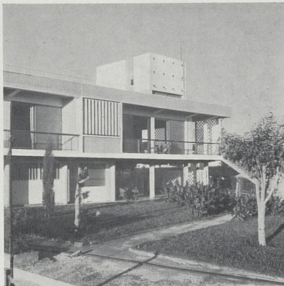
En haut: P. A. Emery et Miquel. Ecole à Château-Neuf, El-Biar (Alger), 1956. Vue générale. En bas: P. A. Emery et Miquel. Villa Lehalle à Moretti-Plage, Alger, 1956. Détail et vue générale
