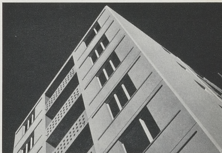
Façade de l'immeuble terminé
