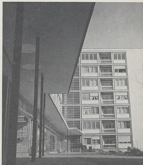
Malagnou-Parc. Façade d'habitation, ossature préfabriquée complètement visible, mise en évidence de la pièce comme module.
