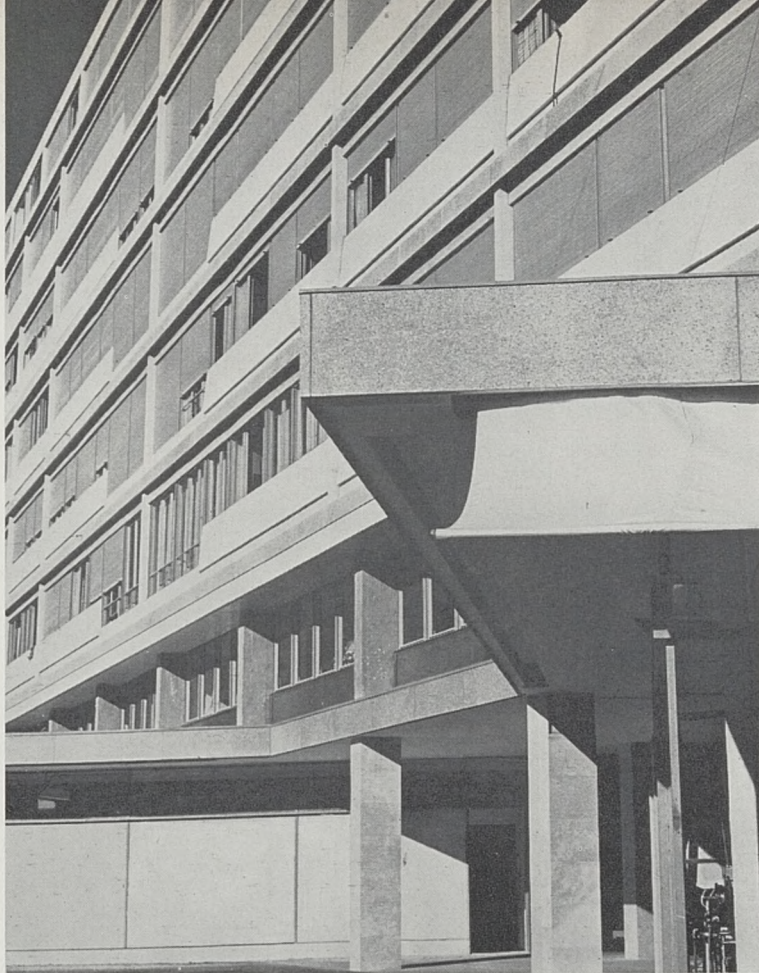
Terreaux-Cornavin. Façade d'habitation, ossature à l'intérieur, le module est l'appartement.
