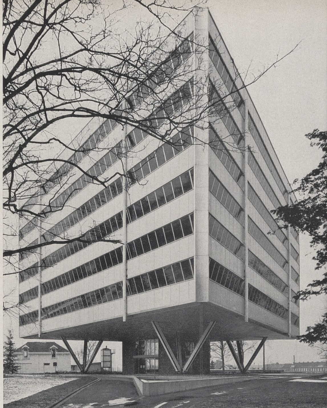
Le bâtiment vu de l'accès dans le parc. On aperçoit l'entrée du bâtiment dans le noyau central et le bâtiment métallique qui repose sur 3 points d'appui.
