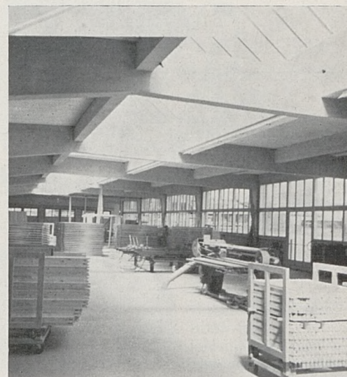
En haut: l'usine, façade principale; (à droite, le bâtiment administratif avec fenêtre basculante Carda; à gauche, le silo). Au milieu: la halle des machines. Ci-contre, la halle de montage
