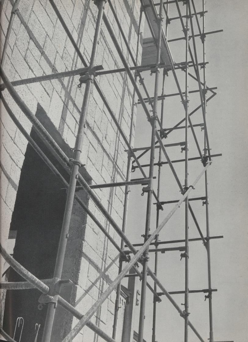
Les étais supportent une grande charge concentrée et permettent ainsi de réduire la « forêt » de bois en quelques rangées d'étais métalliques, qui, en plus, peuvent être nivelés sans peine à chaque hauteur. La grande résistance de ces étais permit le développement d'un autre outil rationnel pour la construction,
