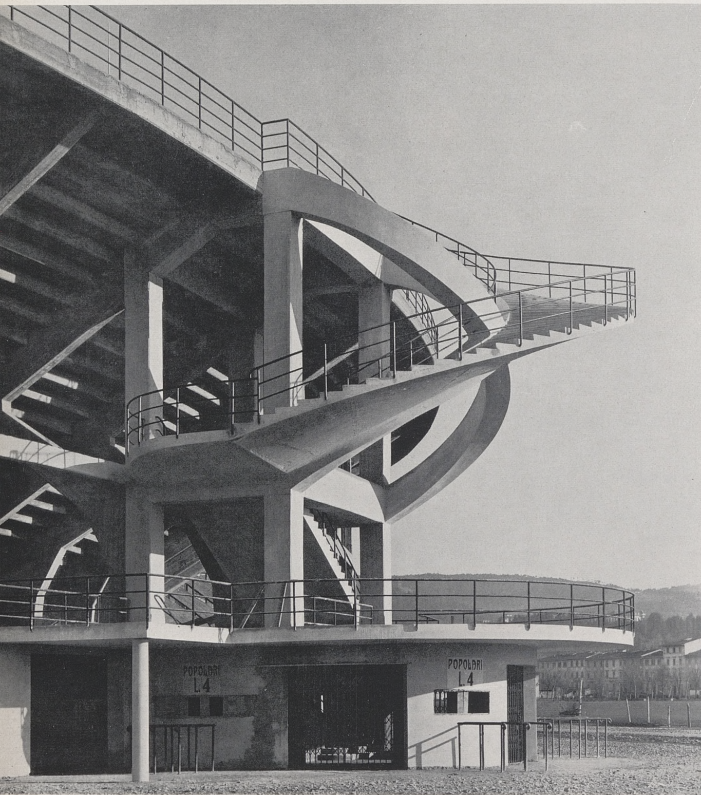
Stade communal de Florence 1930-1932 Escalier hélicoïdal en porte-à-faux à plan semi-circulaire La rampe mesure 3 m de largeur
