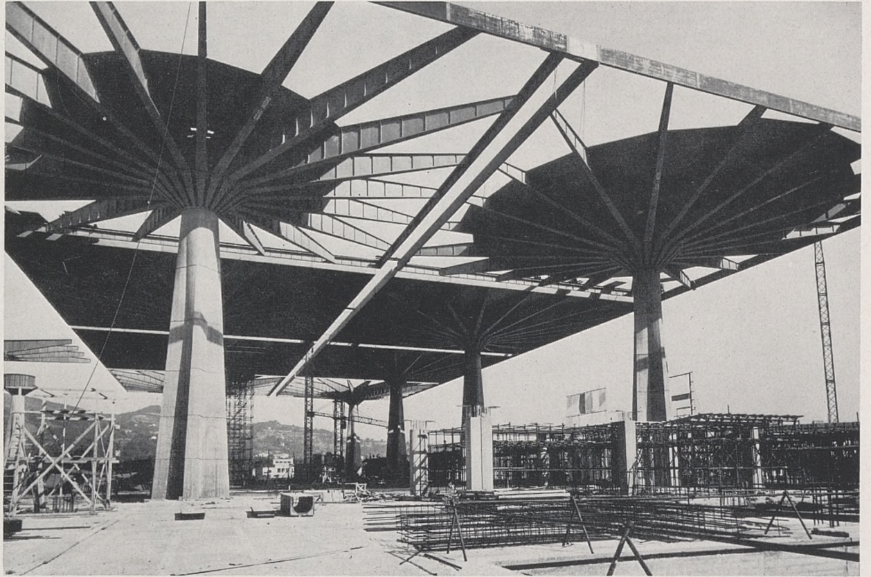
Palais du travail Groupe d'éléments de la toiture en acier en construction
