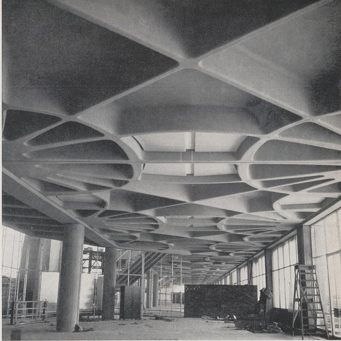
Vue de la poutraison isostatique de l'étage intermédiaire
