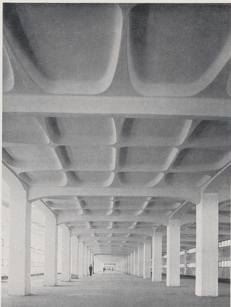
Nouvelle Manufacture des Tabacs de la régie italienne à Bologne. 1949-1952 Etudes de poutraisons à nervures isostatiques pour le bâtiment des ballots Vue intérieure du magasin des tabacs Poutraisons à nervures isostatiques exécutées sur coffrages en fer-ciment
