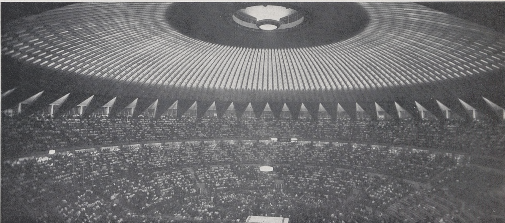
Coupole à éléments préfabriqués
