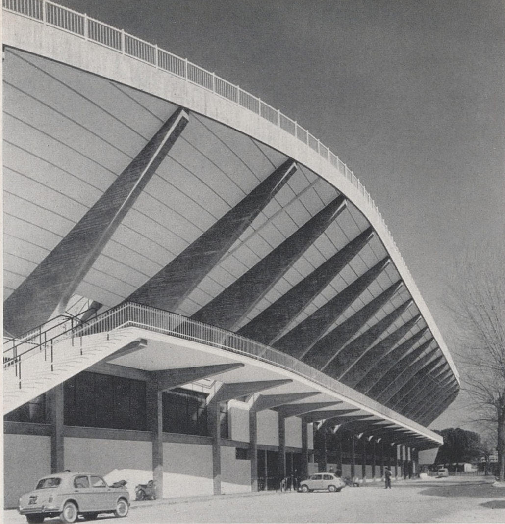
Détail extérieur de la tribune en porte-à-faux Plan général
