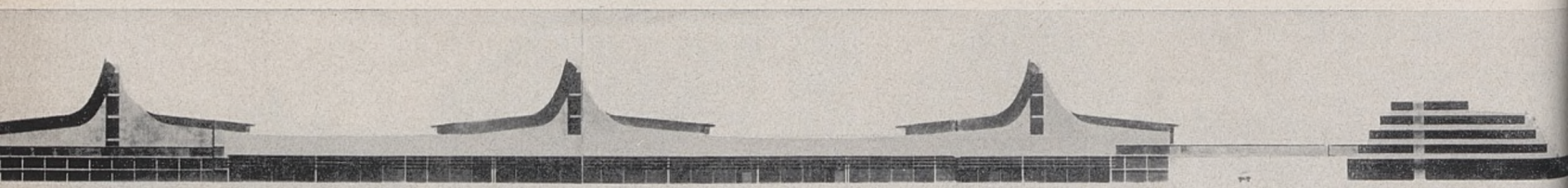
La façade côté entrepôts
